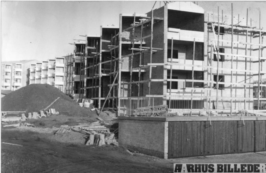
Søvangen under opførelse 1955
